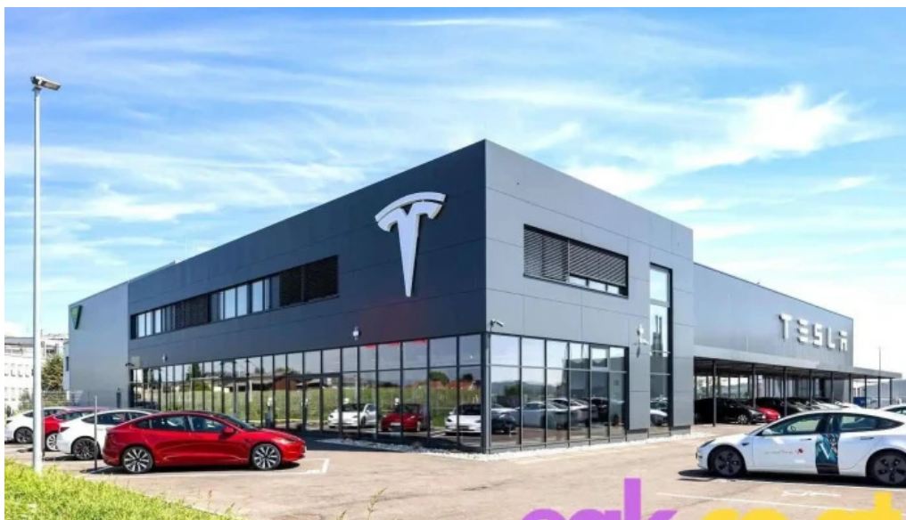
Tesla center graz kalsdorf kalsdorf bei graz
