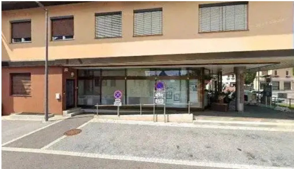
Ladestation für elektrofahrzeuge alle
