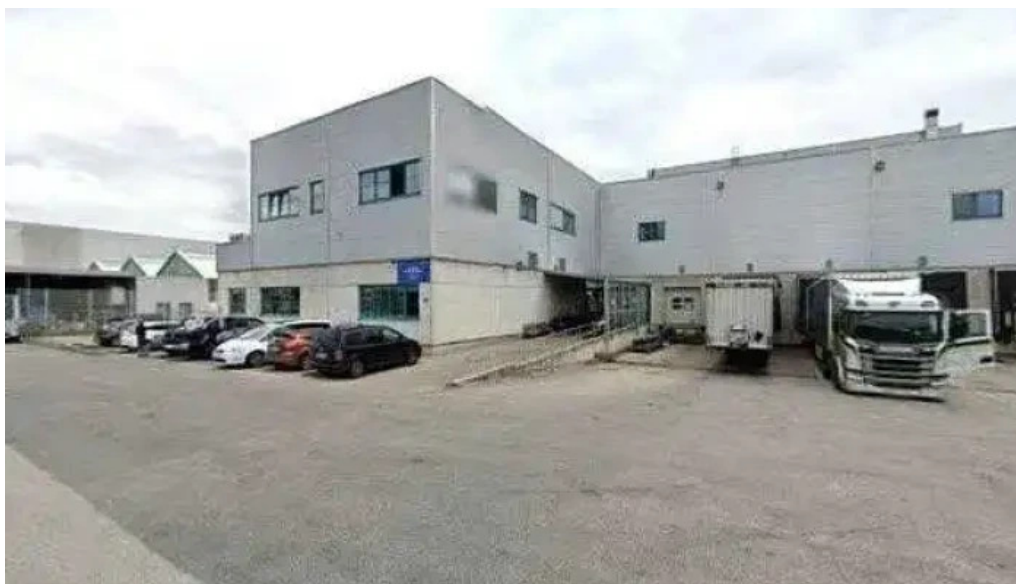
Ochsner wärmepumpen werk dietach alle
