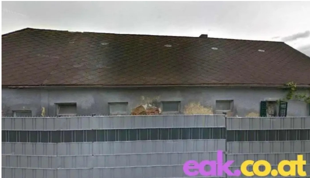
Bioenergie gabersdorf gmbh gabersdorf
